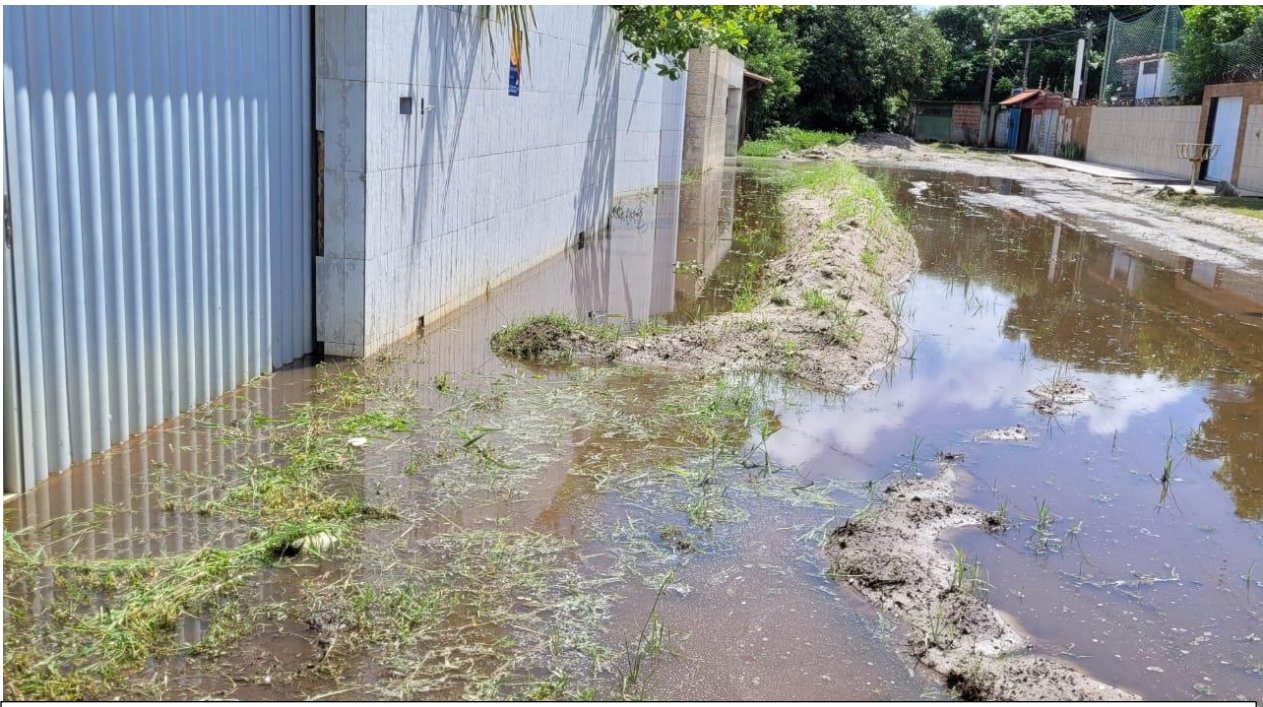
Marechal Deodoro/AL, foto recente: Rua completamente inundada consequência do fechamento do canal que existia para escoamento das águas e do adensamento habitacional na área. (maio, 2024).
