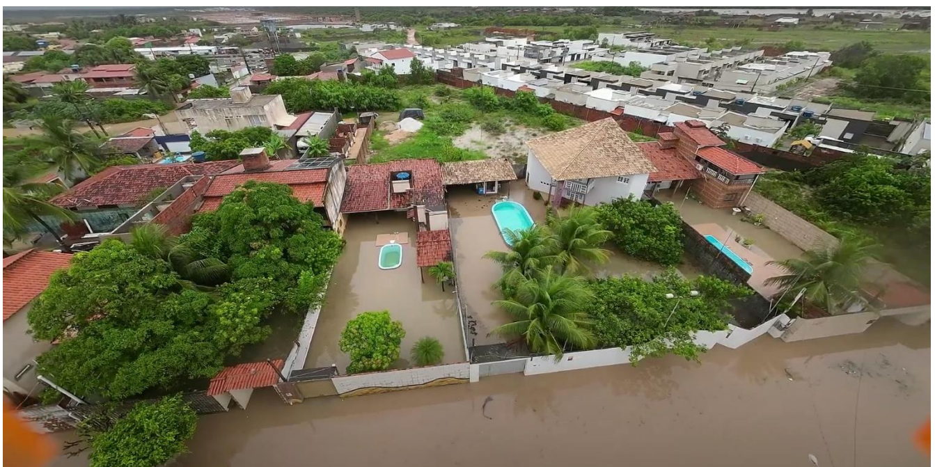
Marechal Deodoro/AL: Arruamento e terrenos inundados , Também vários imóveis (inverno 2023).
