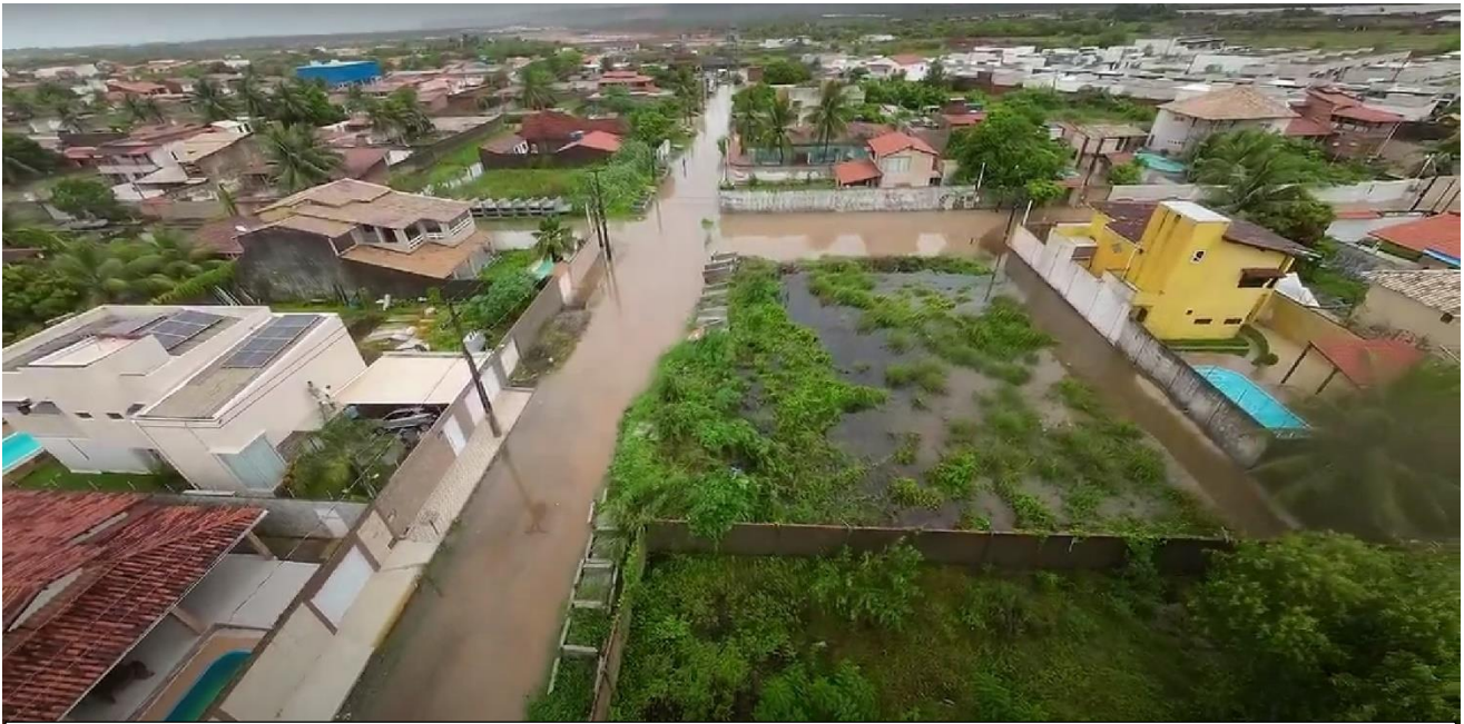
Marechal Deodoro/AL: Arruamento e terrenos todos inundados, sem ter o devido escoamento (inverno 2023)
