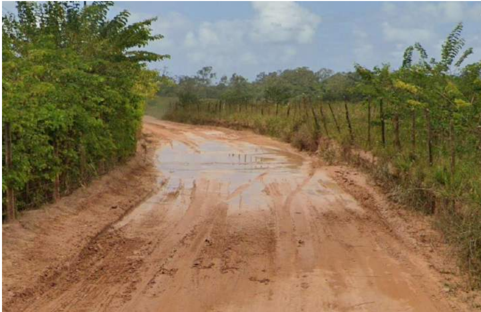
Imagem 1. Trechos das estradas de acesso à CTRM.
